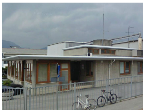
Complesso industriale CERAMICA DOLOMITE-
