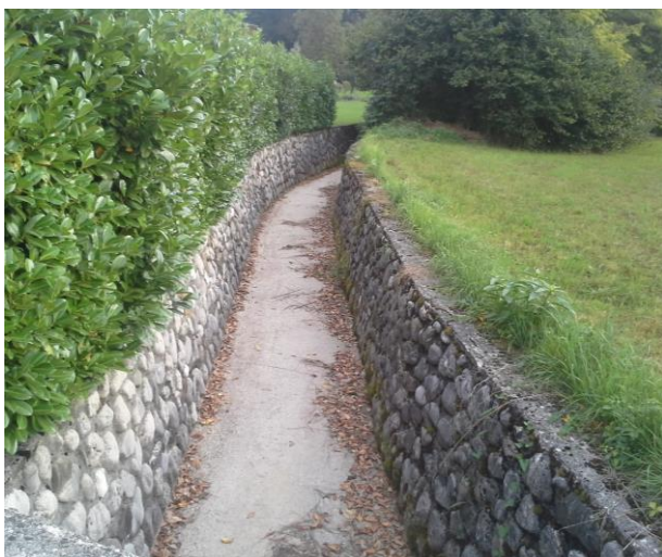
Alveo a monte del tombinamento: sez 2m larghezza 1.75 m altezza
