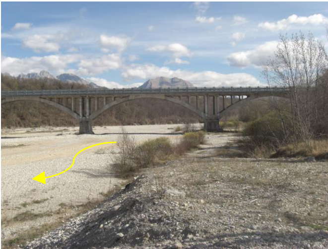
Foto 1: alveo del Fiume Piave in corrispondenza di Ponte S. Felice.
