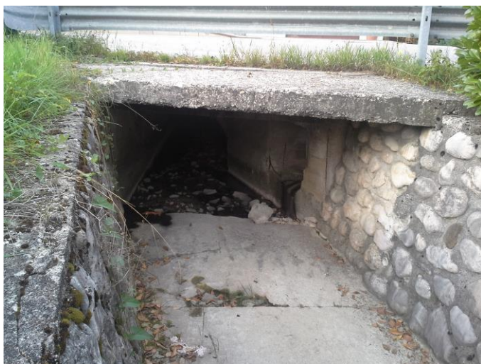
Ingresso tratto tombinato: sez 1.45 m larghezza 1.00 m altezza
