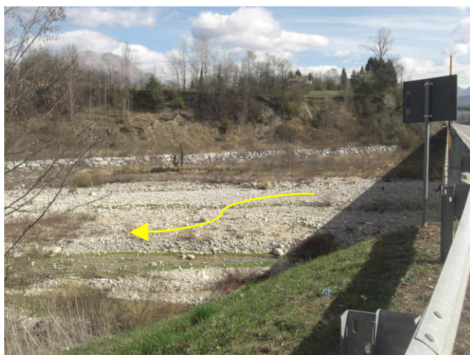
Foto 5: scogliere sul torrente Limana in corrispondenza del ponte lungo la statale n°10
