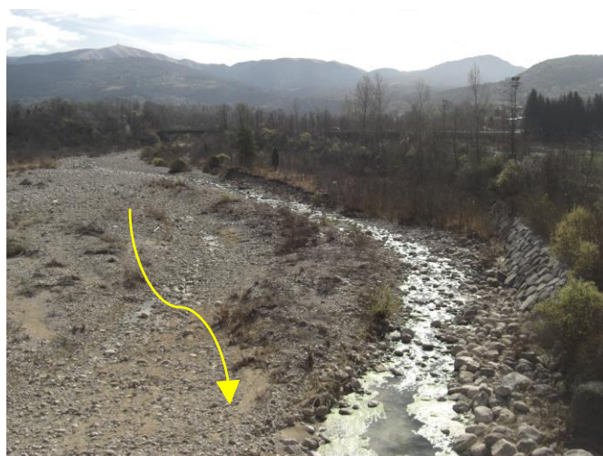
Foto 6: torrente Limana verso monte in corrispondenza del ponte lungo la statale n°10
