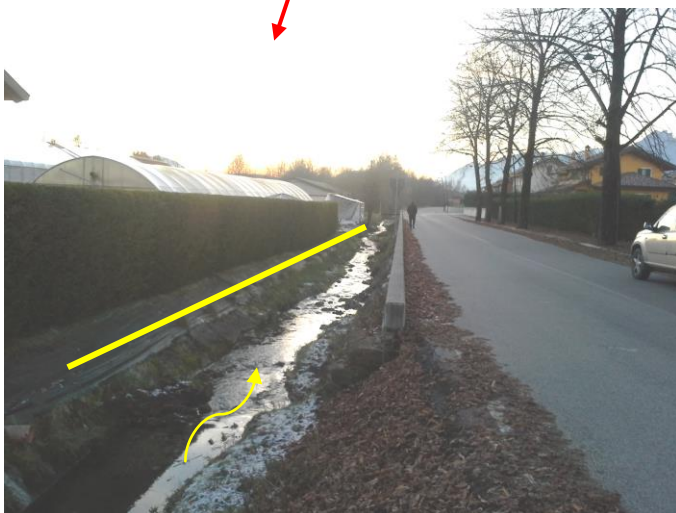
Realizzazione argine come in destra idrografica
