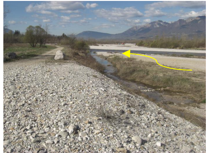
Foto 2: rialzo arginale in sinistra idrografica appena a valle di ponte S. Felice.
