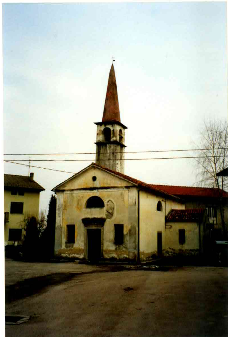
FACCIATA LATO OVEST
