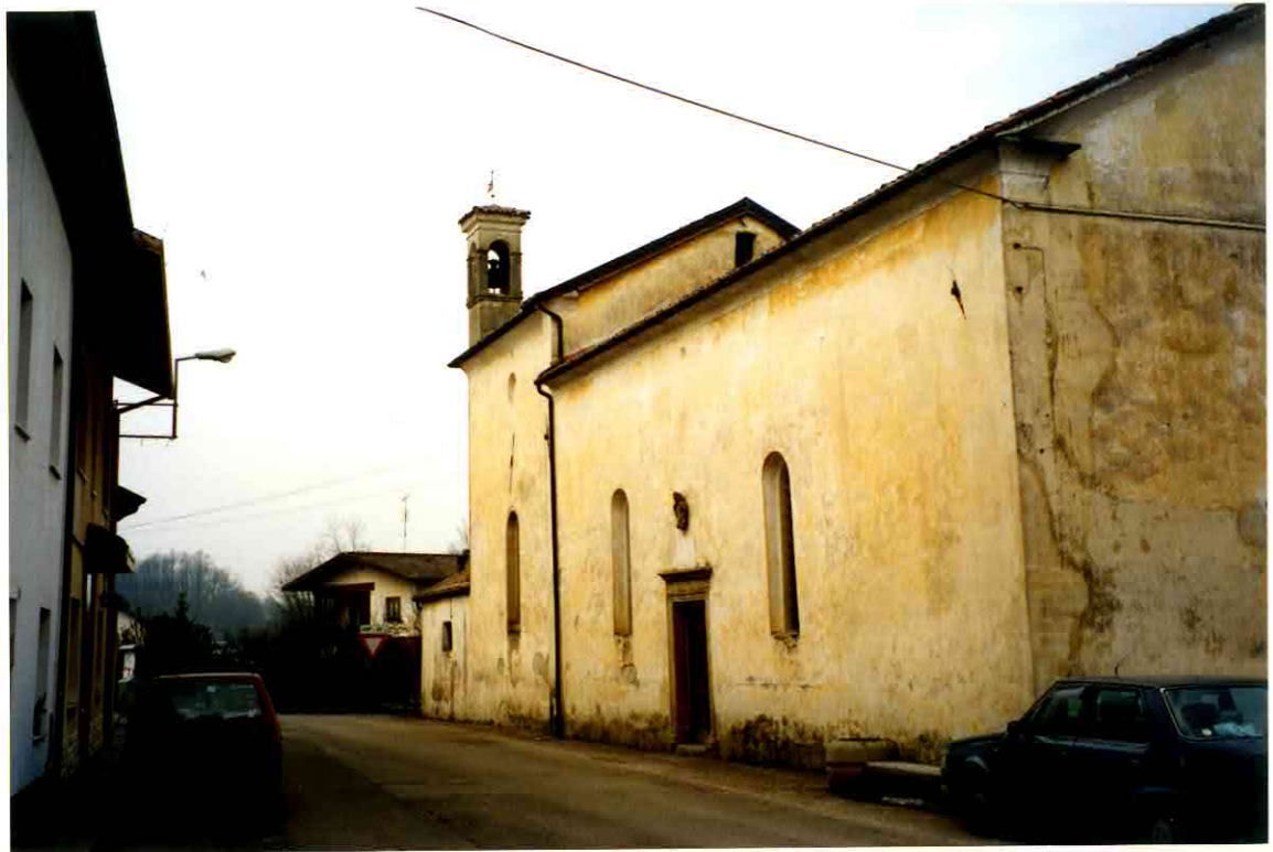
FACCIATA LATO SUD-EST
