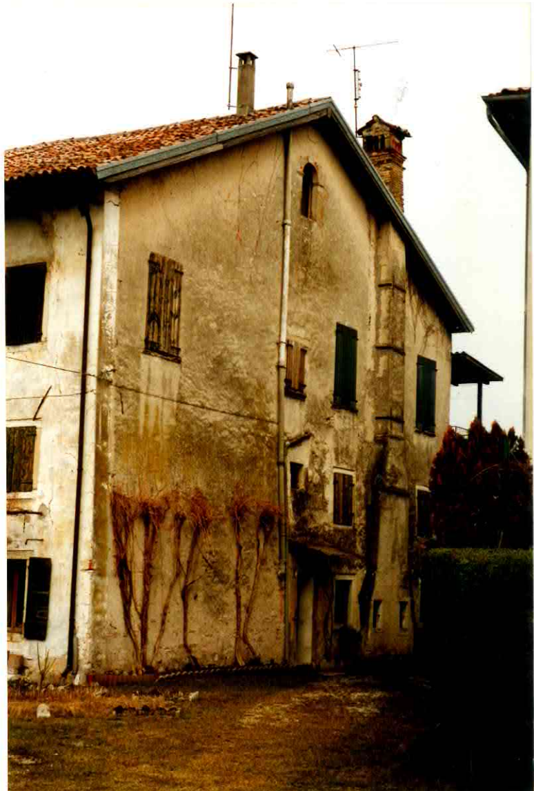
FACCIATA LATO EST
