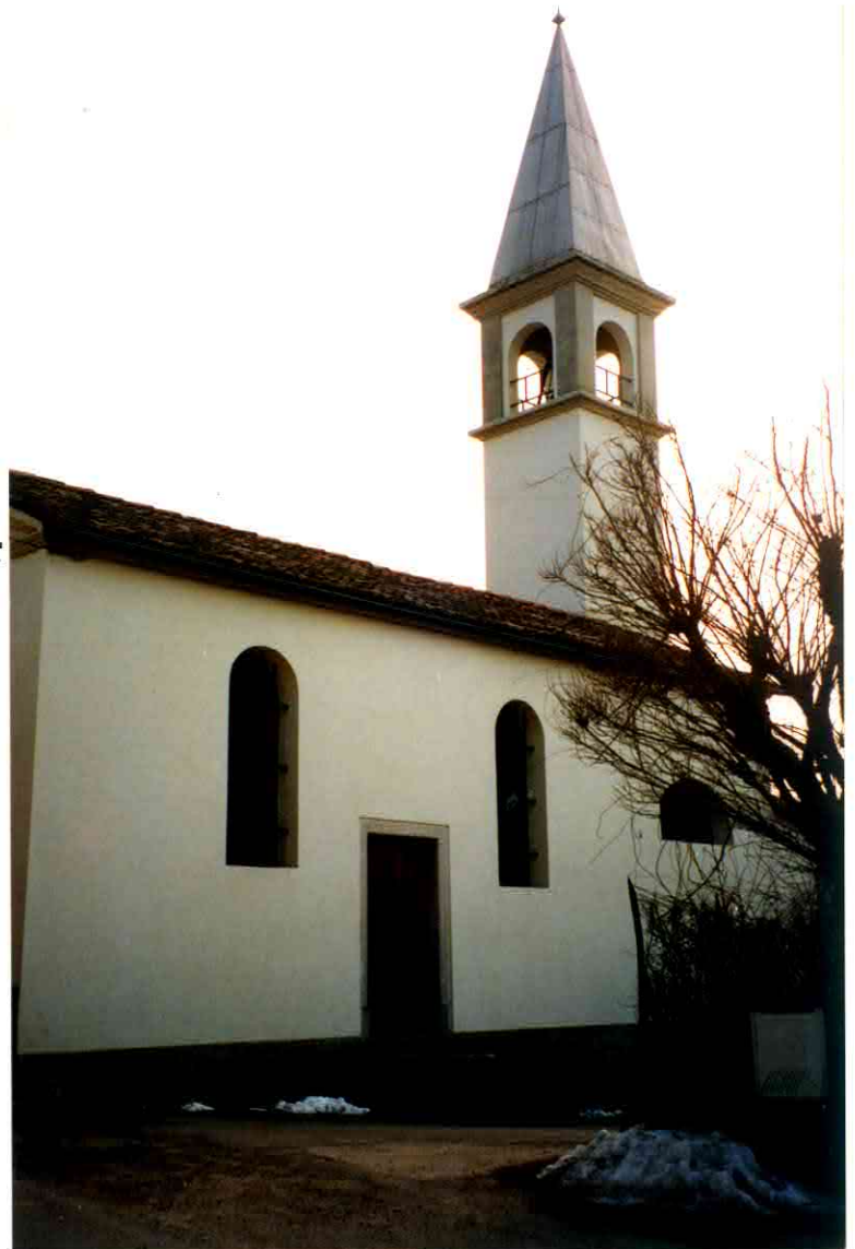
FACCIATA LATO NORD-OVEST
