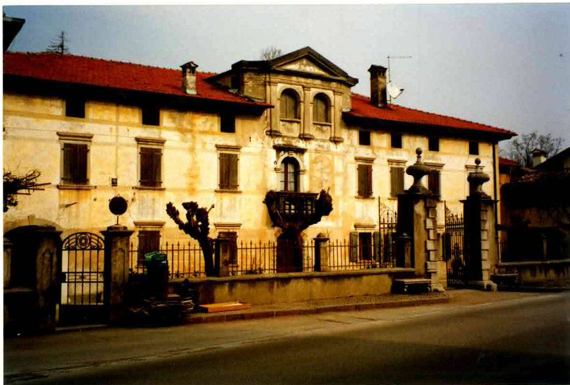
FACCIATA LATO SUD
