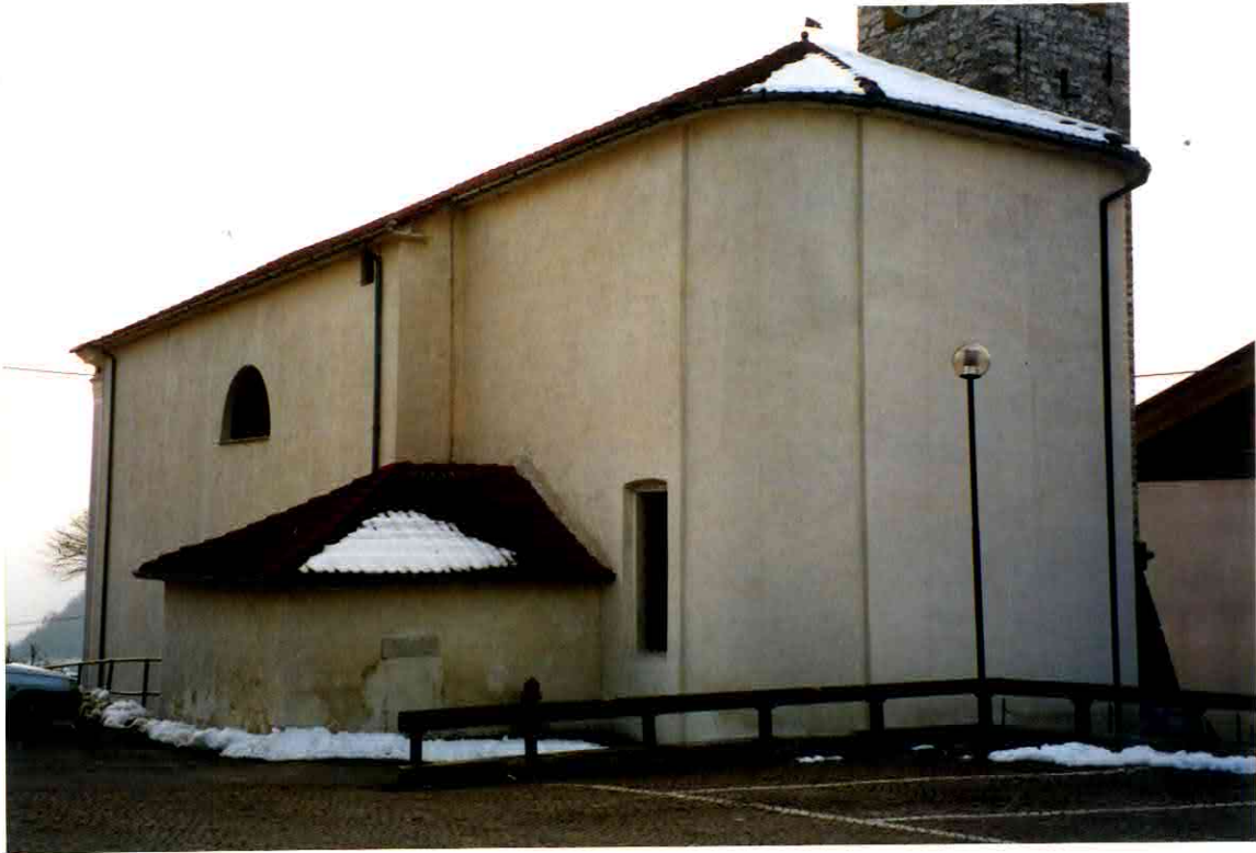
FACCIATA LATO NORD NORD-EST
