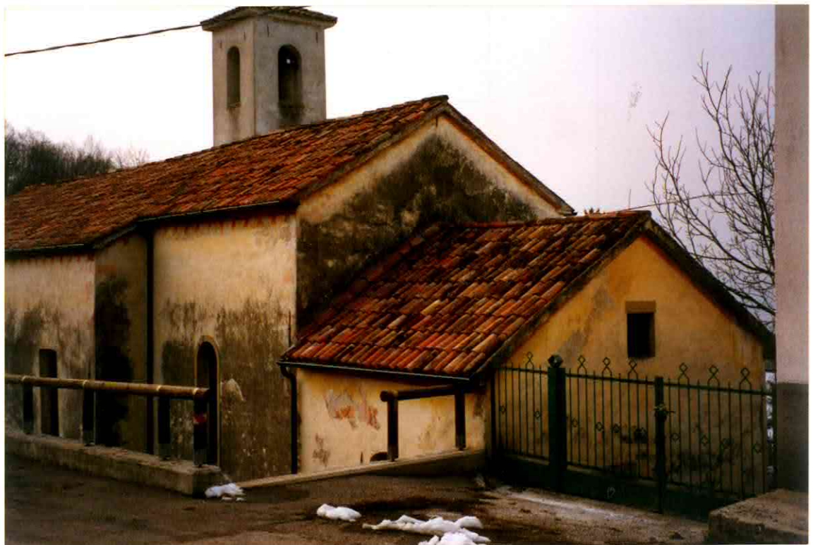
FACCIATA LATO EST
