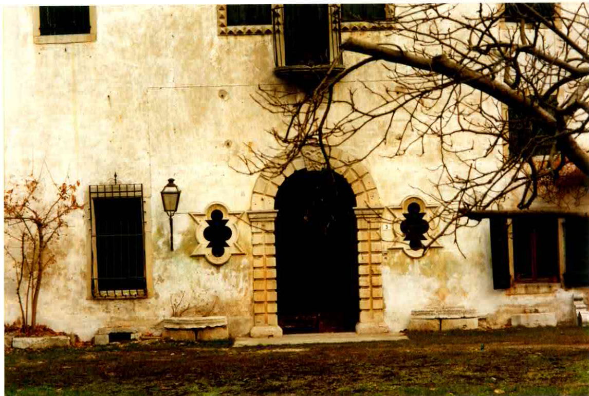
PARTICOLARE DEL PORTALE SULLA FACCIATA SUD
