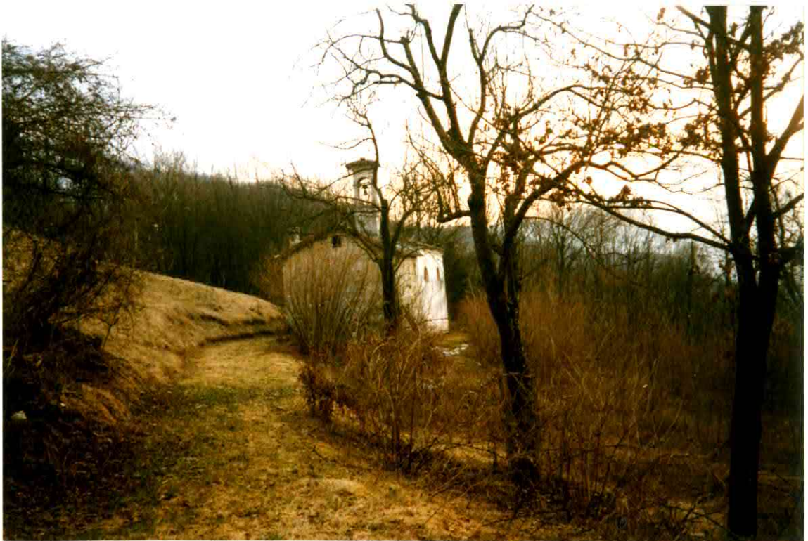
FACCIATA LATO SUD-EST
