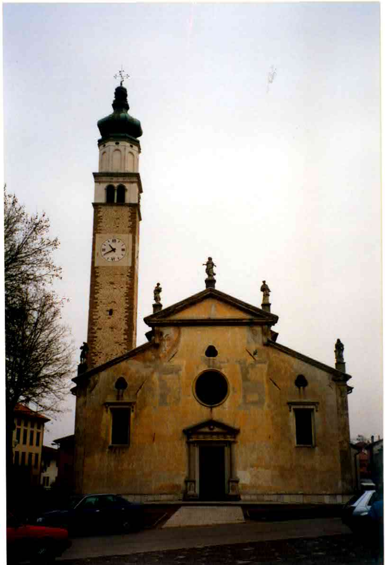
FACCIATA LATO SUD-OVEST
