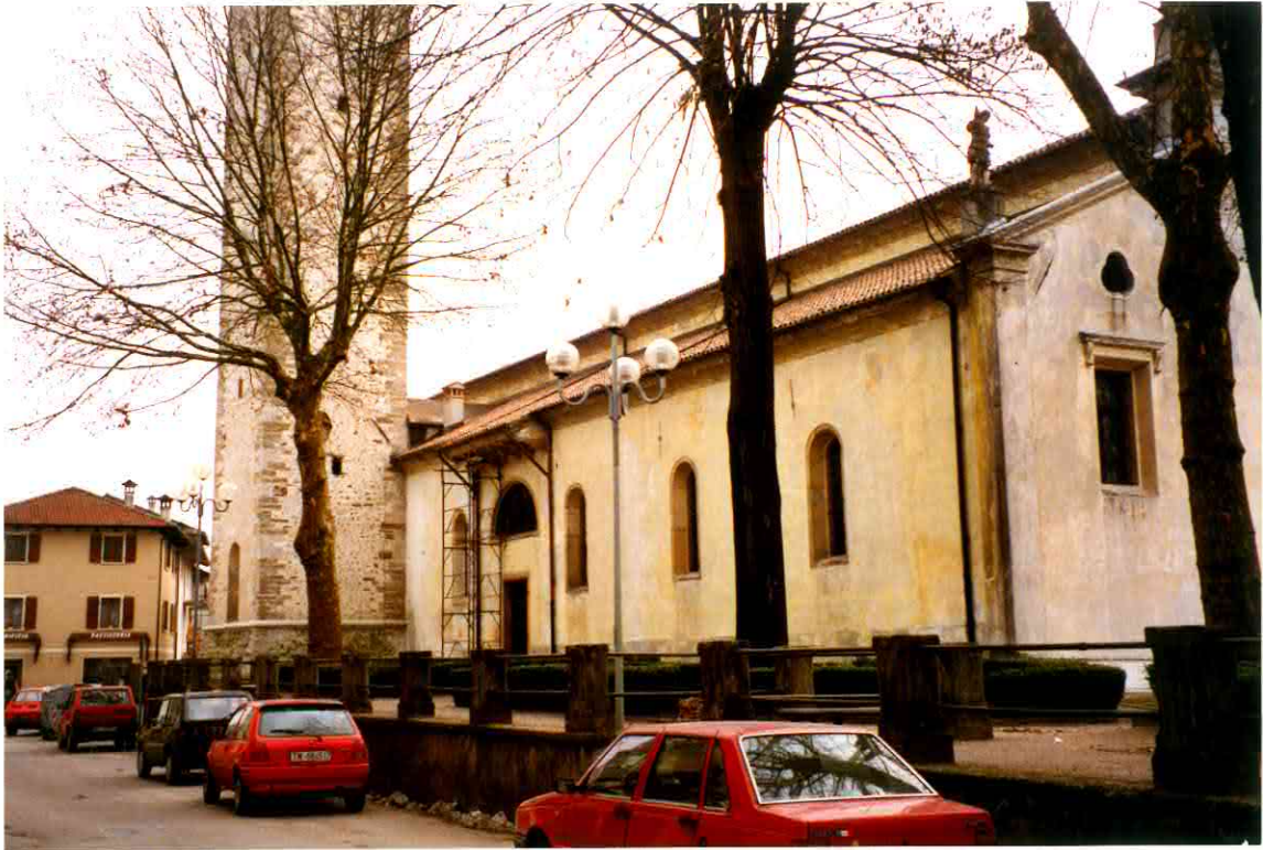
FACCIATA LATO NORD-OVEST
