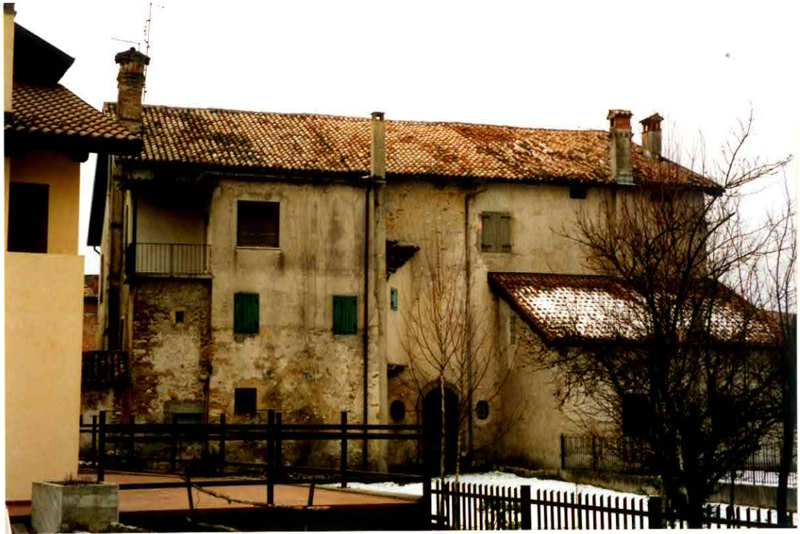
FACCIATA LATO NORD
