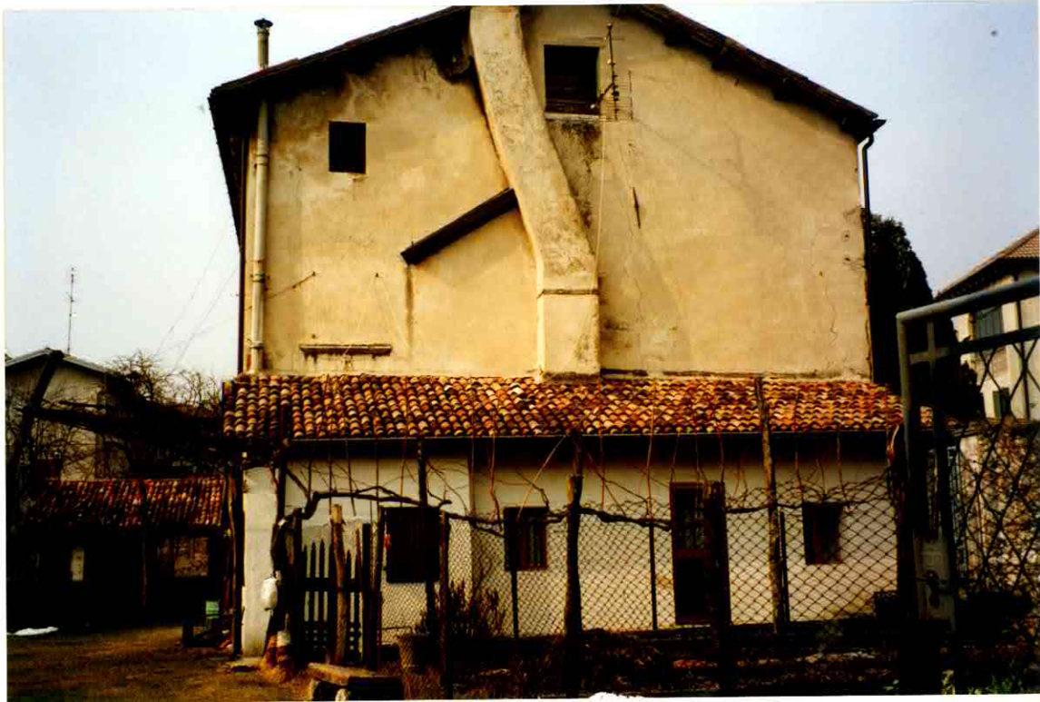
FACCIATA LATO EST
