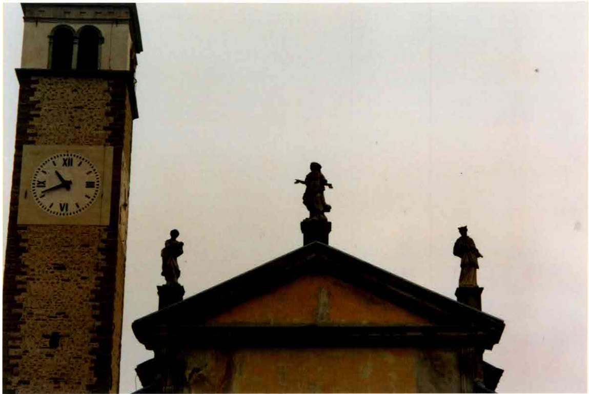
PARTICOLARE DEL TIMPANO
