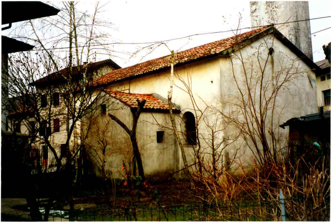
FACCIATA LATO SUD
