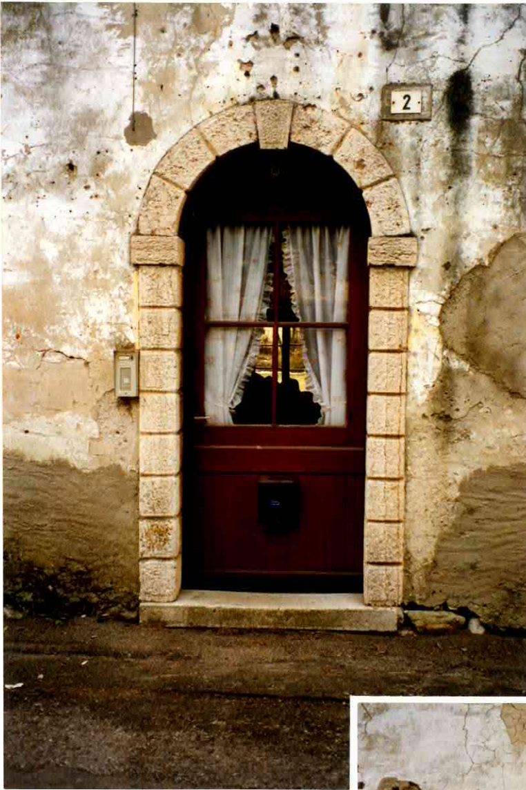
PARTICOLARE DEL PORTALE SUL LATO NORD
