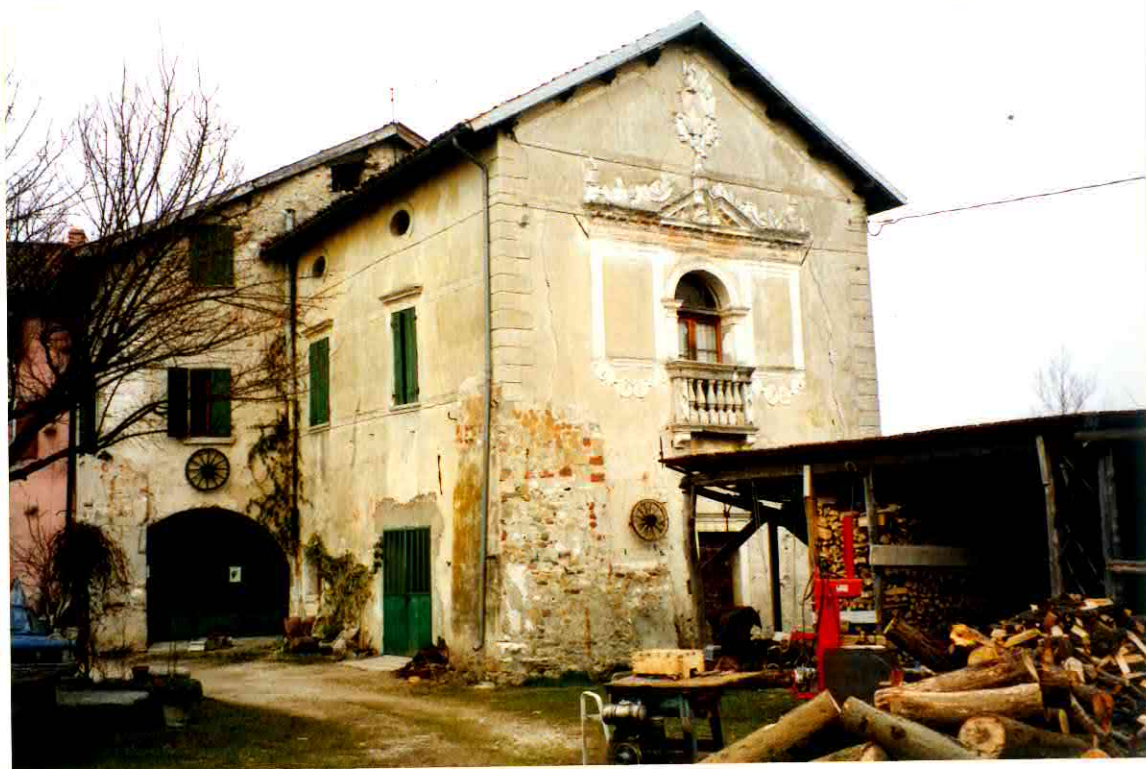
FACCIATA LATO SUD-EST
