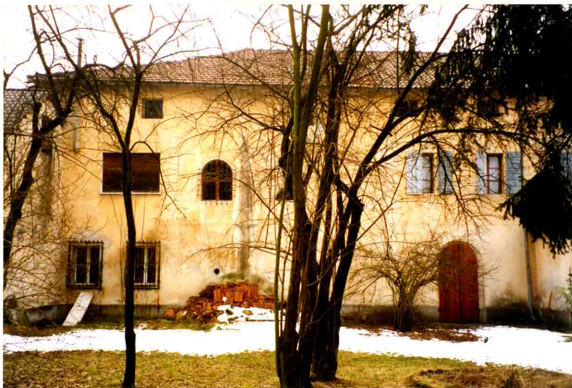
FACCIATA LATO NORD
