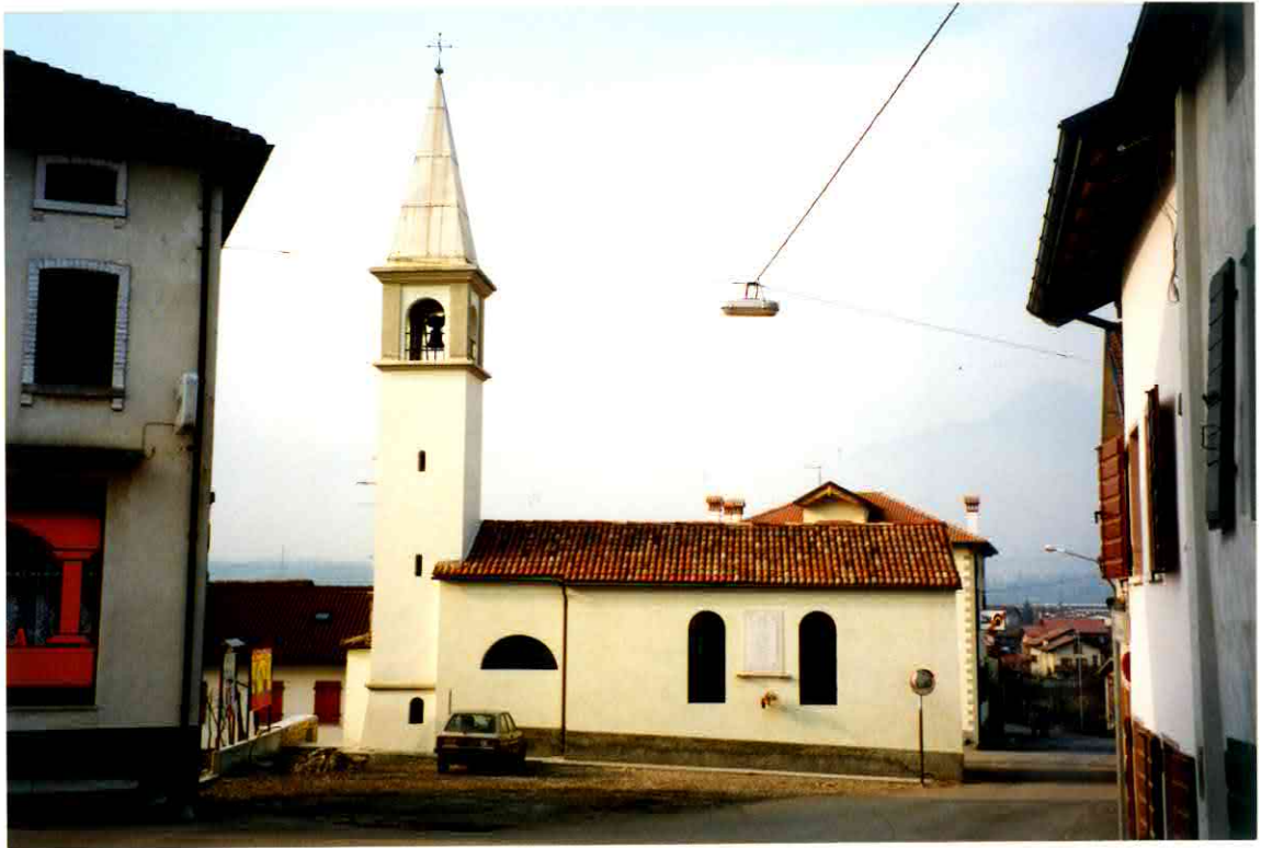
FACCIATA LATO SUD-EST
