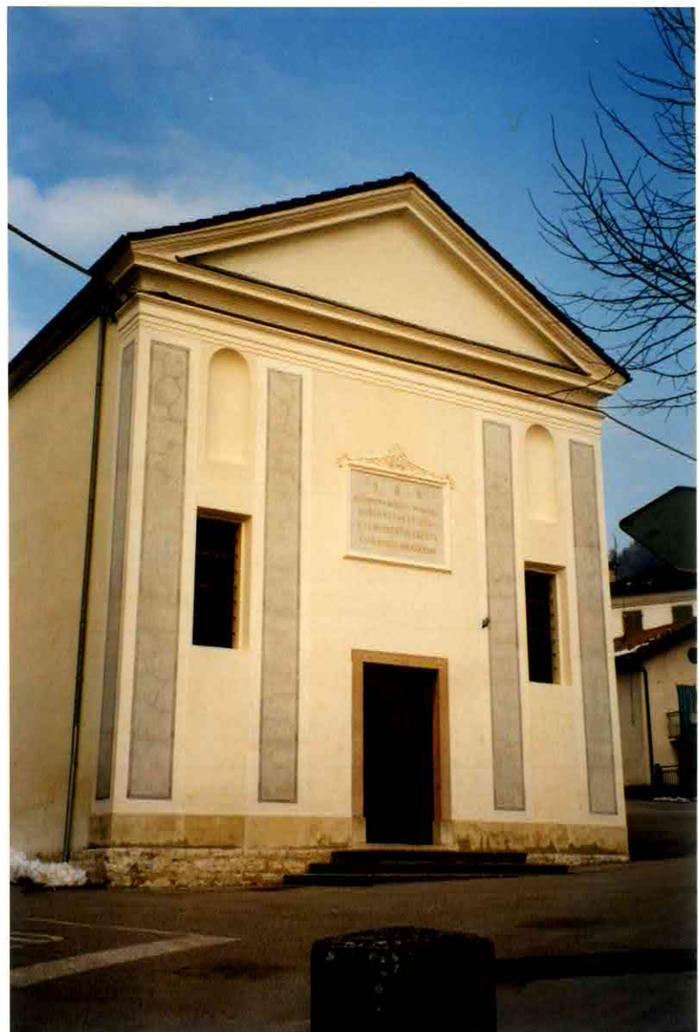
FACCIATA LATO SUD-OVEST
