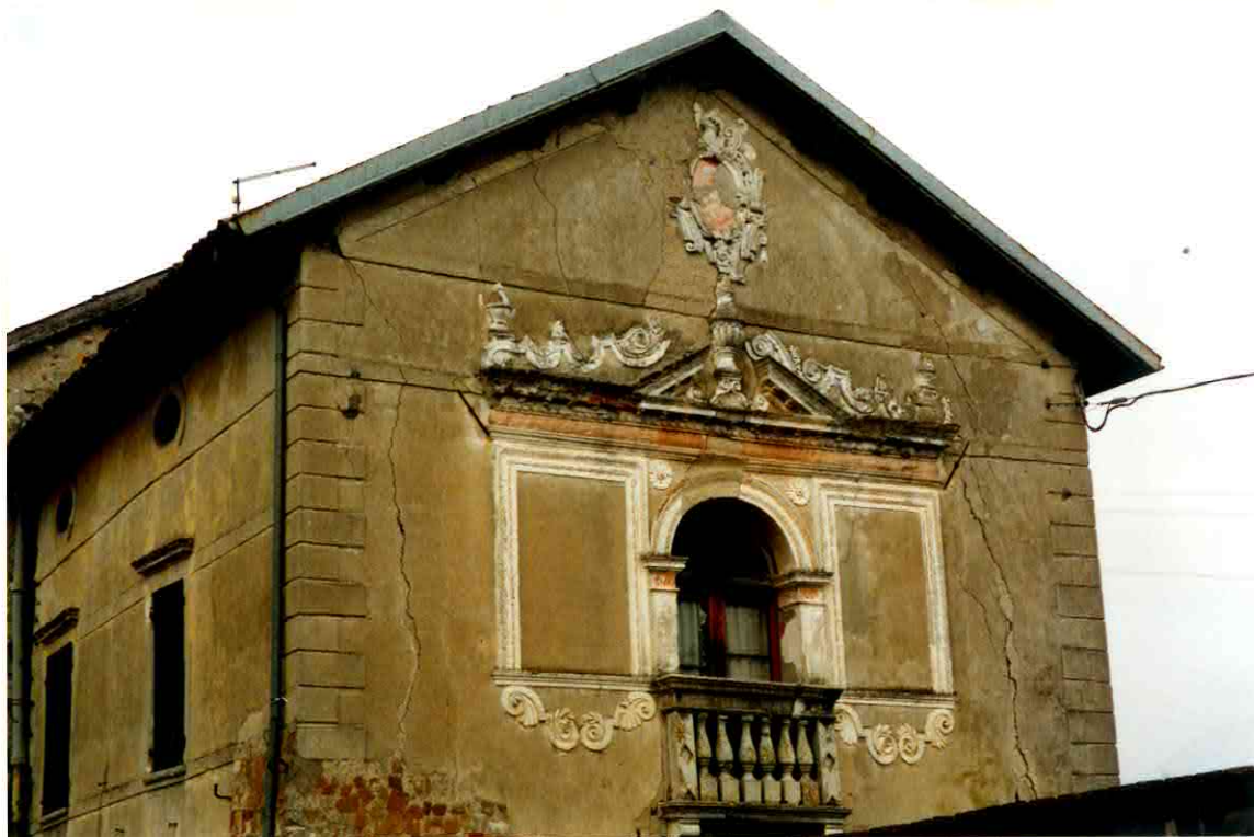
PARTICOLARE DELLA FINESTRA SUL LATO SUD-EST
