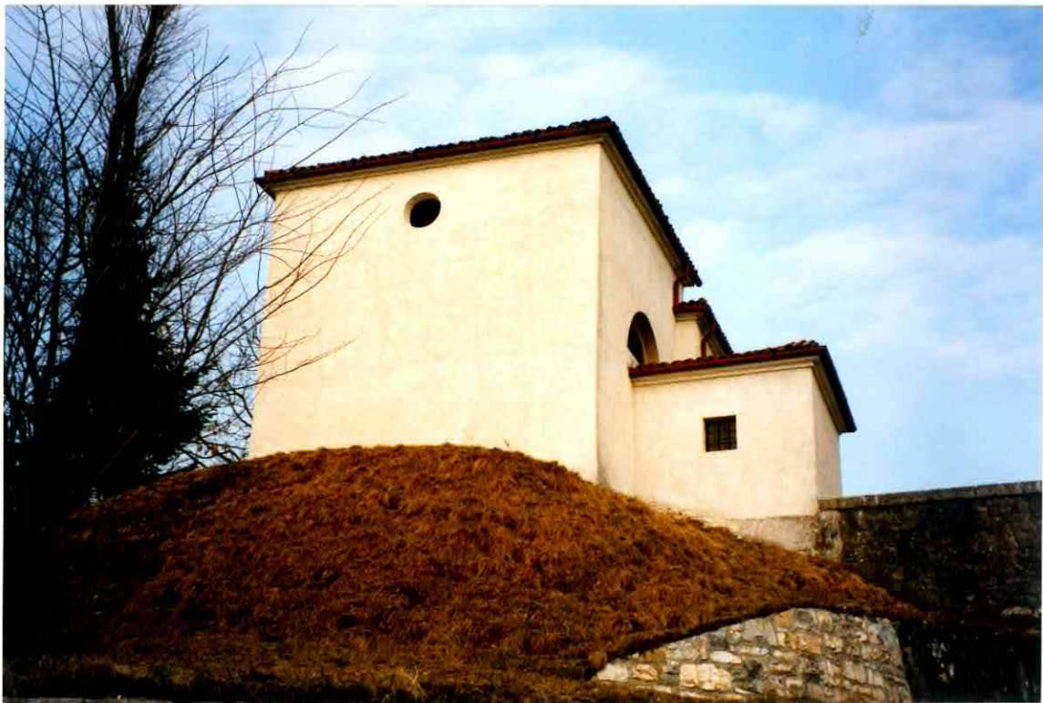
FACCIATA LATO NORD-OVEST
