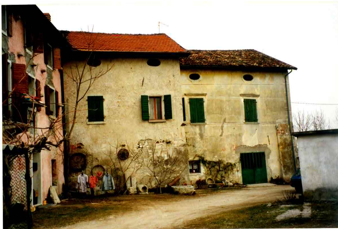
FACCIATA LATO SUD-OVEST
