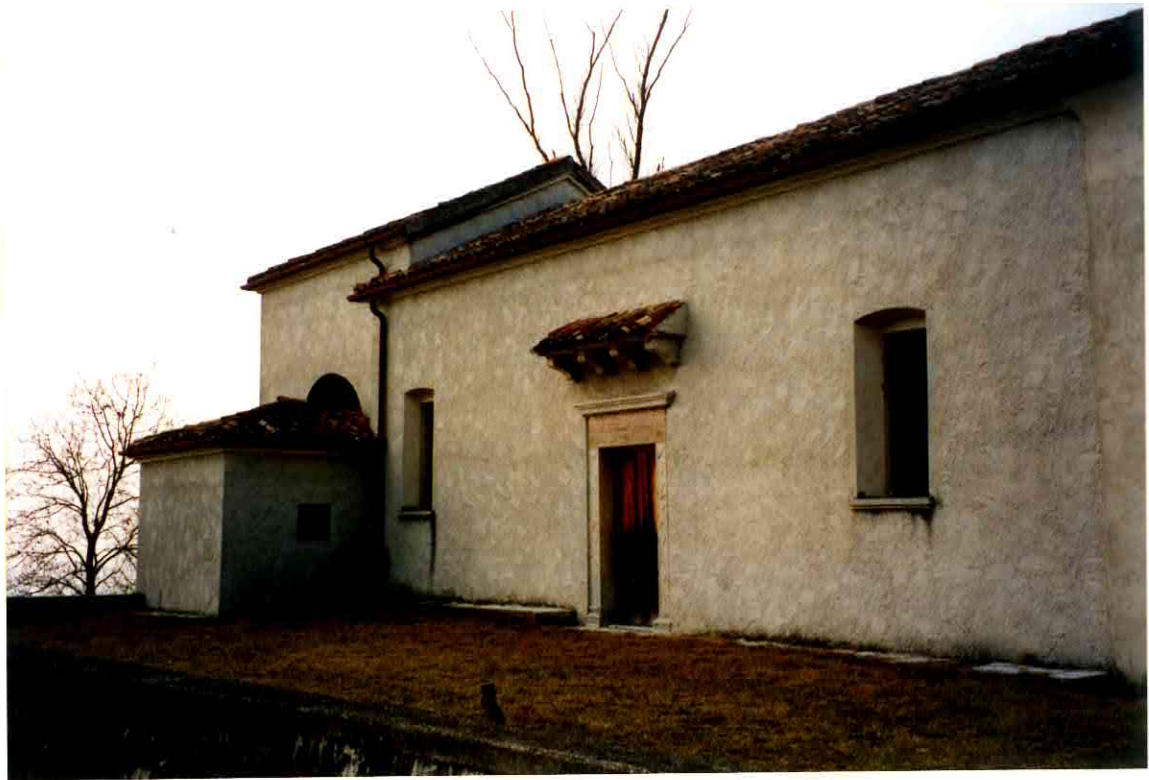
FACCIATA LATO SUD-EST
