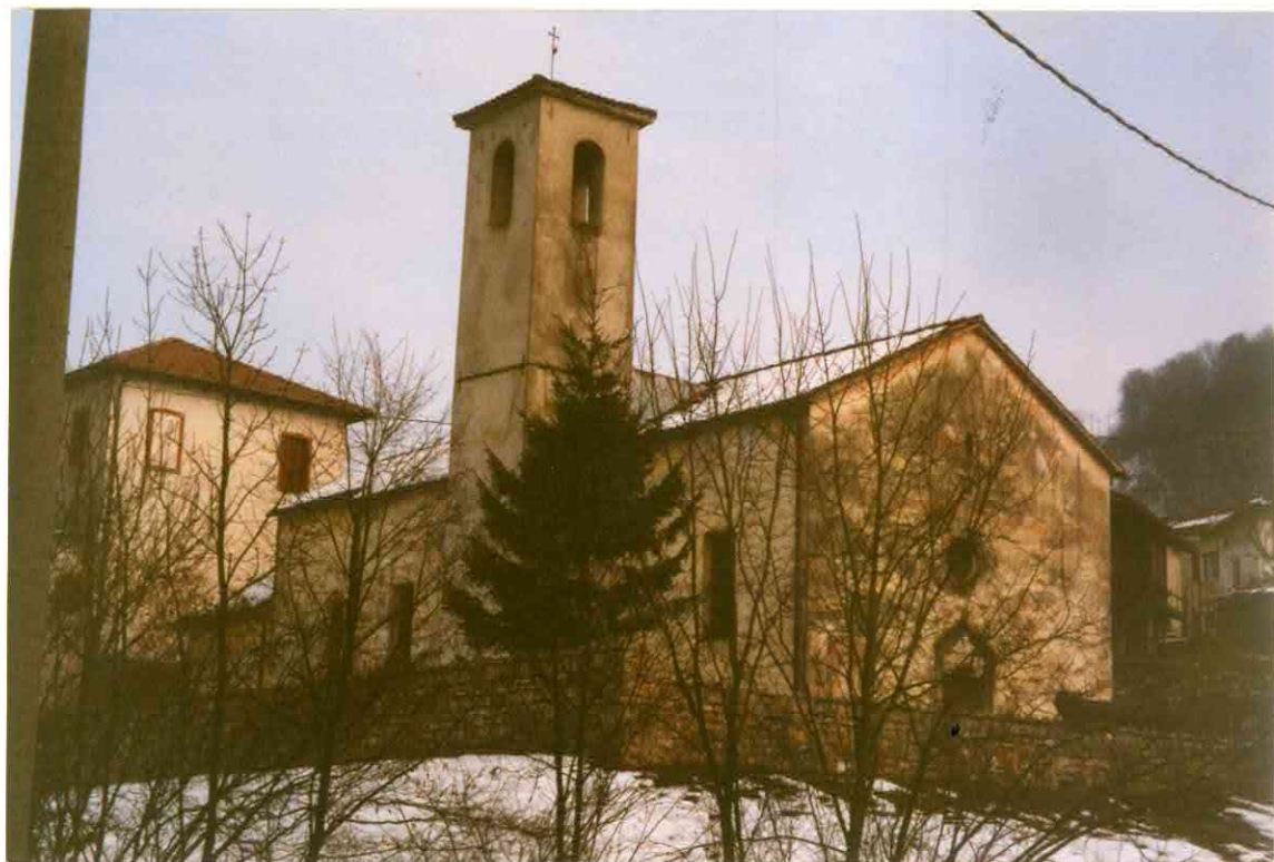
FACCIATA LATO NORD
