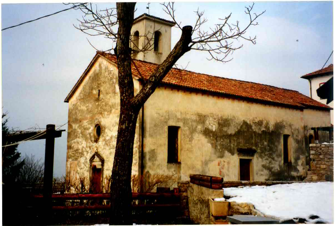
FACCIATA LATO SUD
