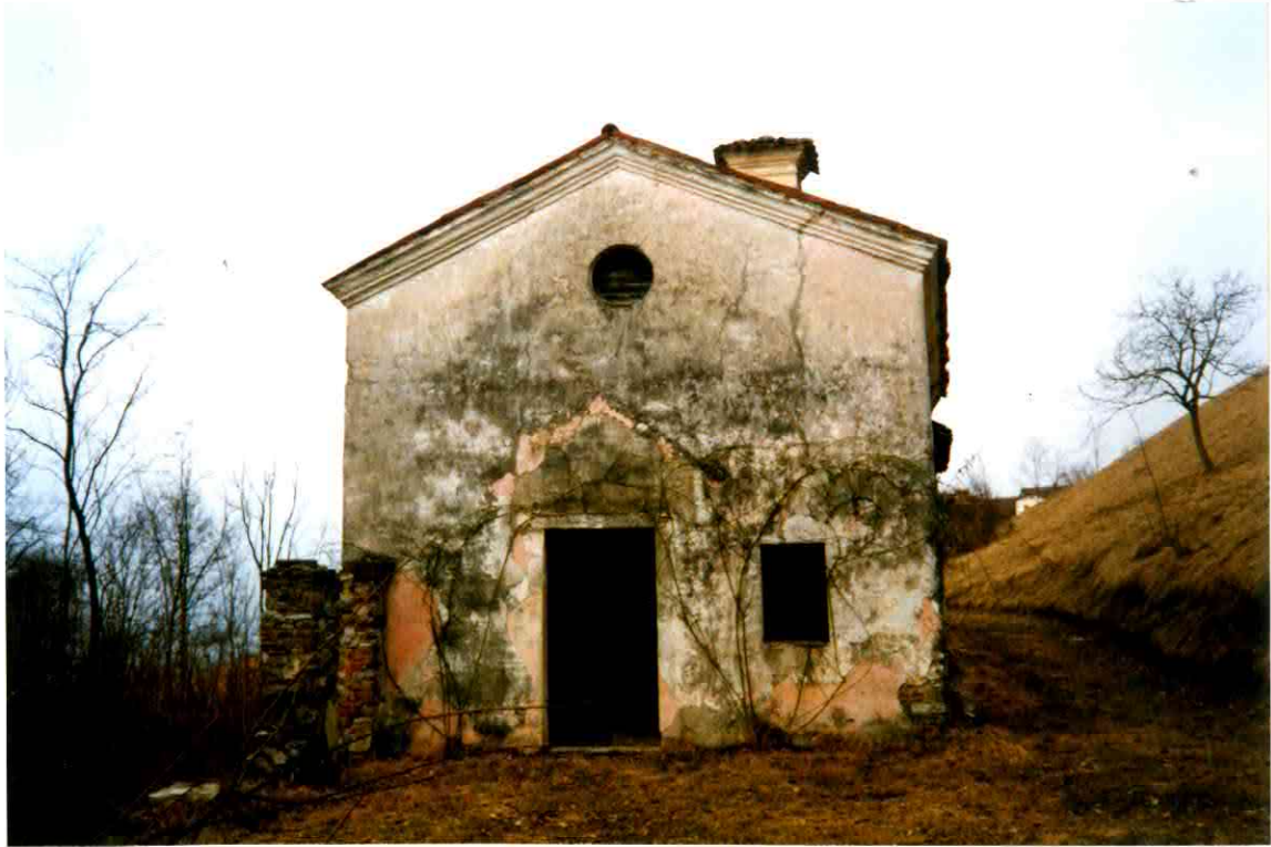
FACCIATA LATO SUD-OVEST
