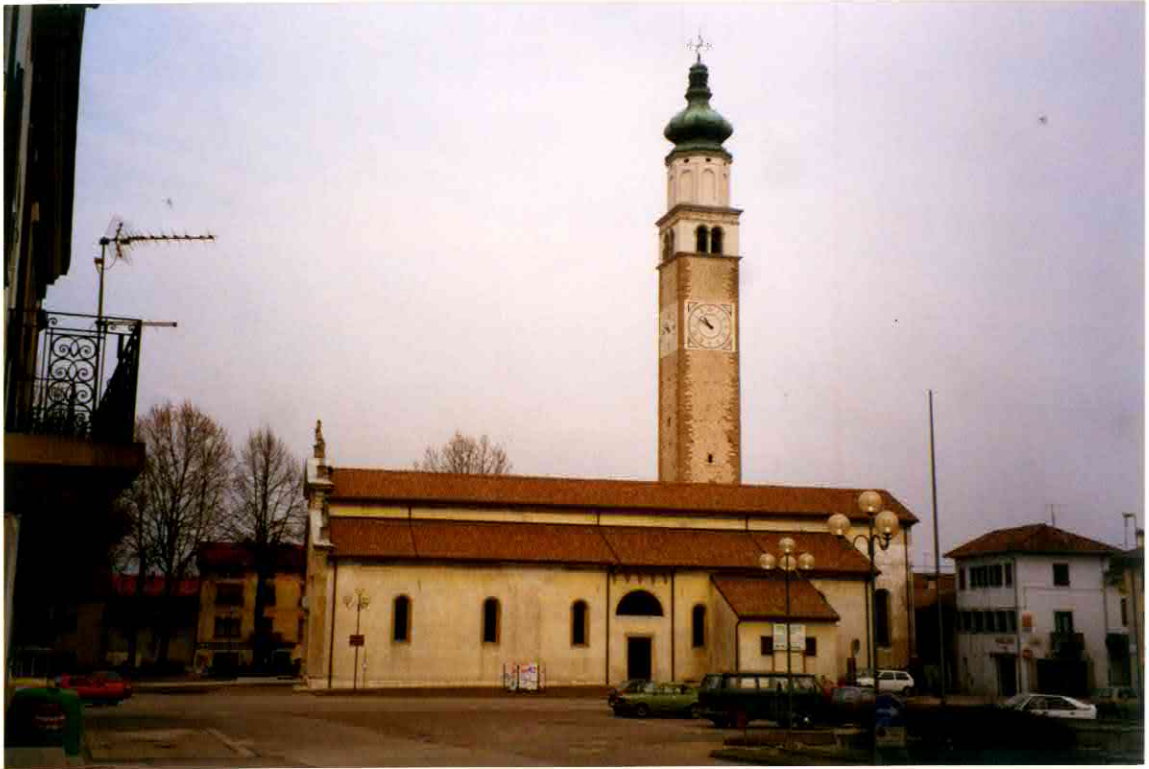
FACCIATA LATO SUD-EST
