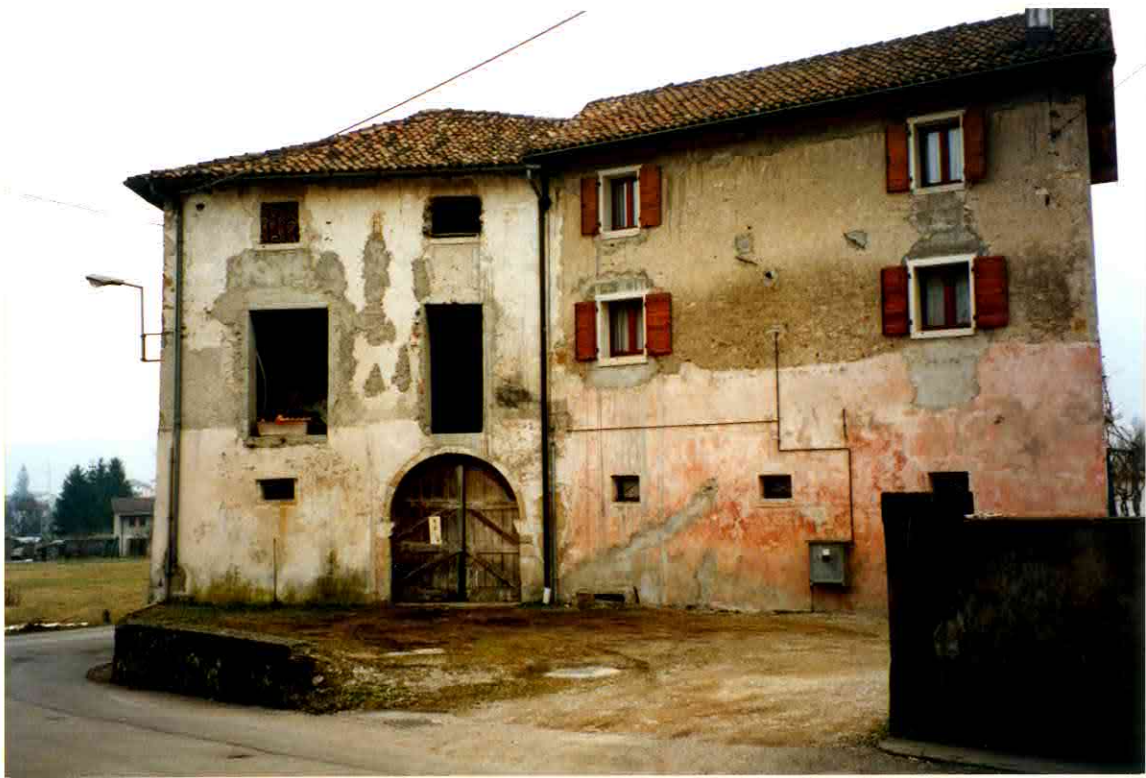
FACCIATA LATO NORD-OVEST
