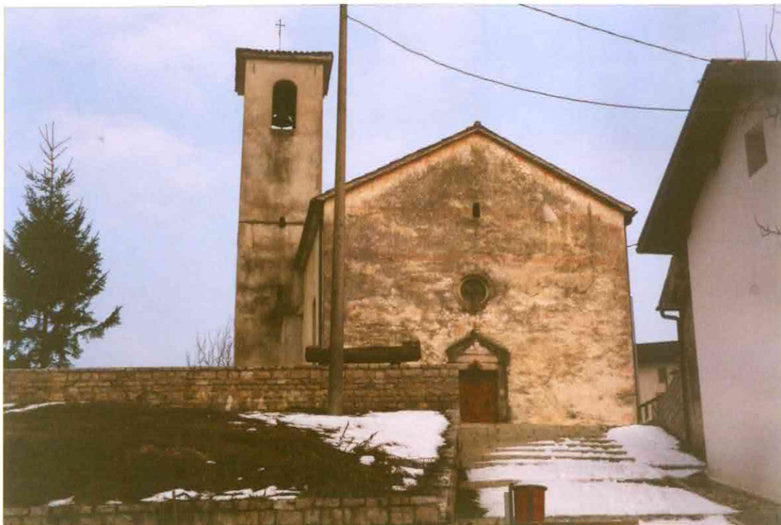
FACCIATA LATO OVEST
