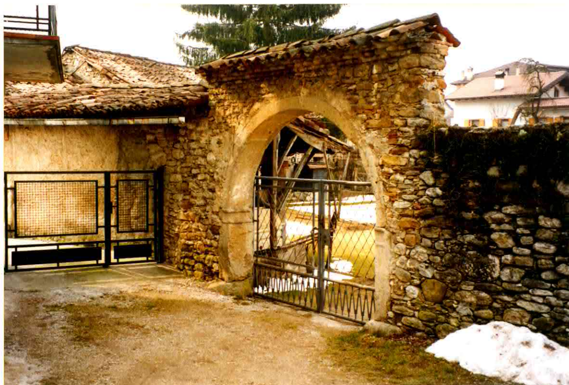
PARTICOLARE DELL'INGRESSO VERSO EST
