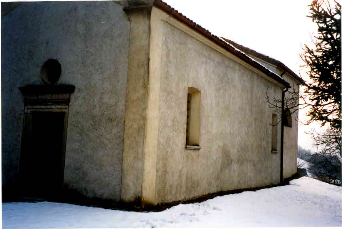
FACCIATA LATO SUD-OVEST
