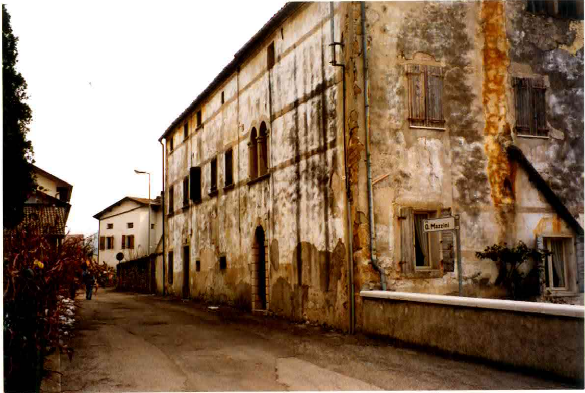
FACCIATA LATO NORD
