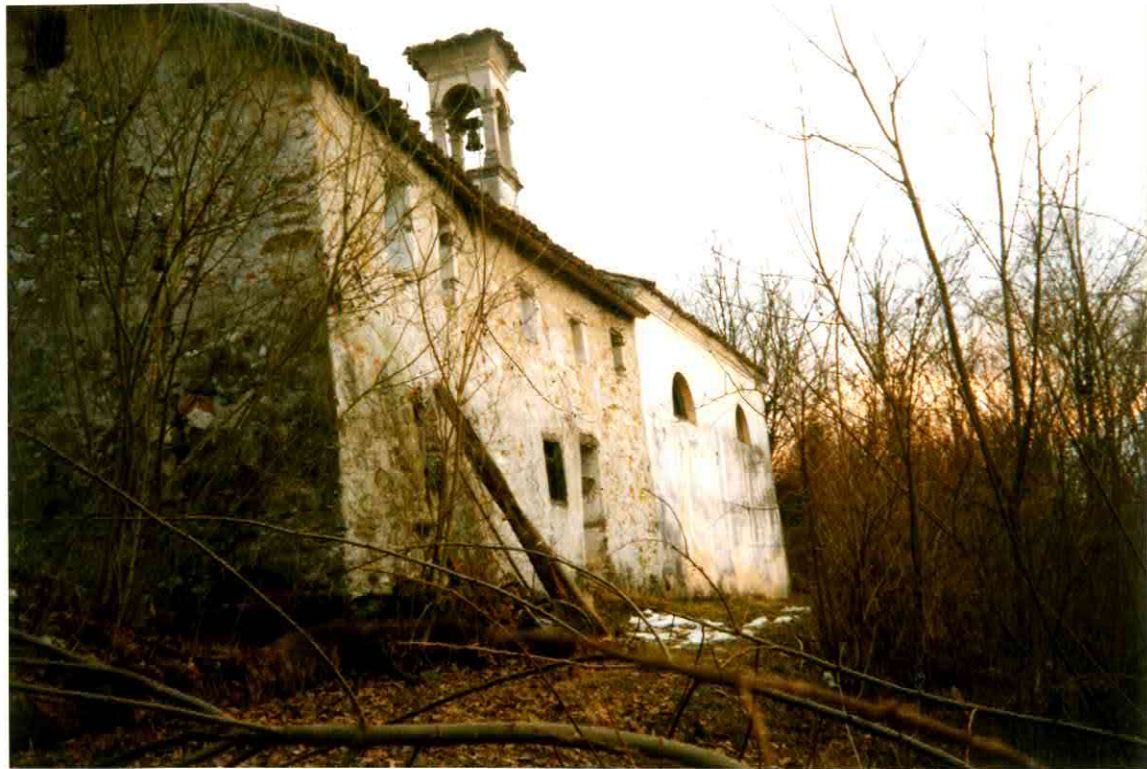
FACCIATA LATO NORD-OVEST
