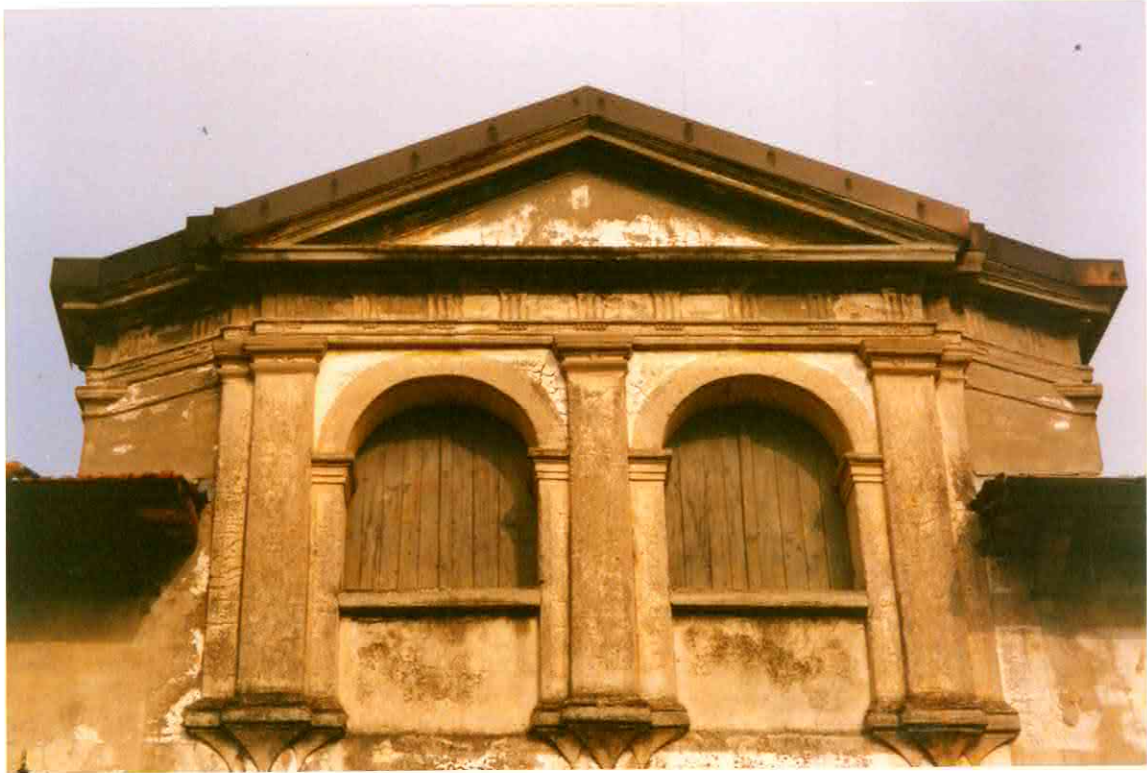
PARTICOLARE DEL TIMPANO
