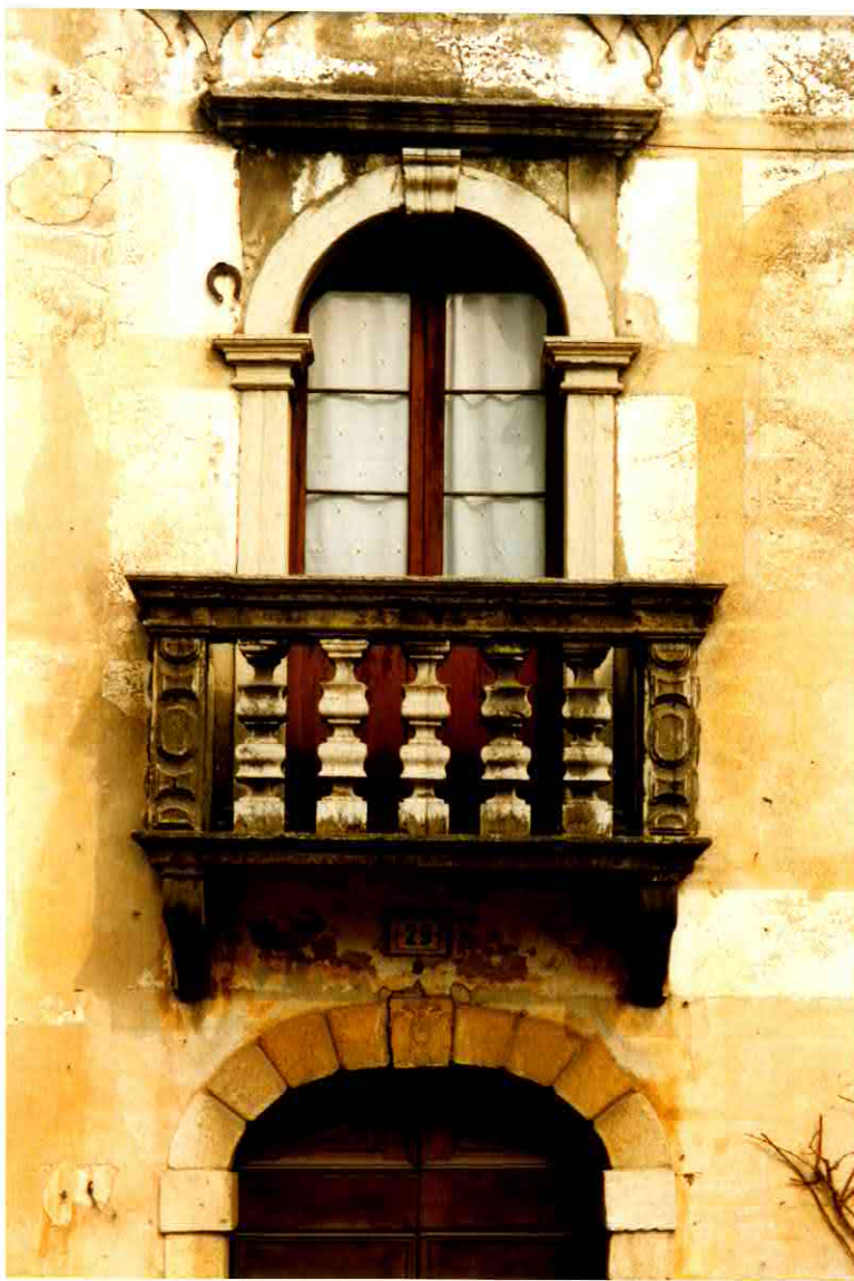
PARTICOLARE DELLA FINESTRA E DEL POGGIOLO AL PRIMO PIANO
