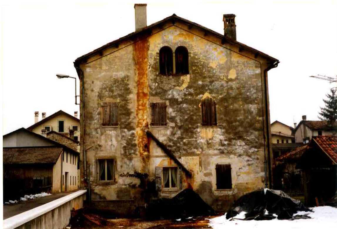
FACCIATA LATO OVEST
