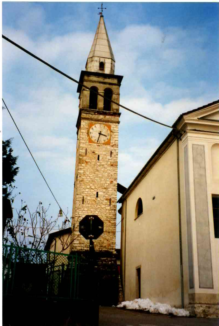
FACCIATA LATO NORD-OVEST
