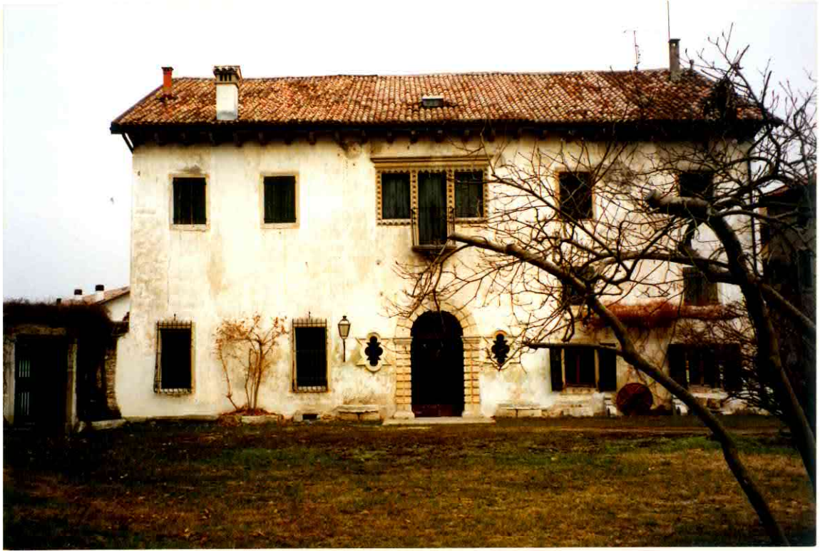
FACCIATA LATO SUD
