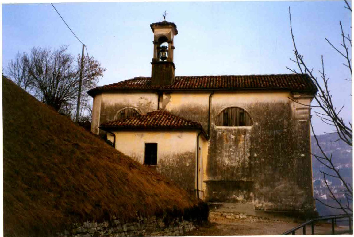
FACCIATA LATO SUD-OVEST
