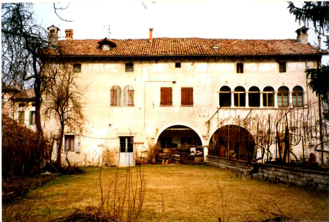
FACCIATA LATO SUD
