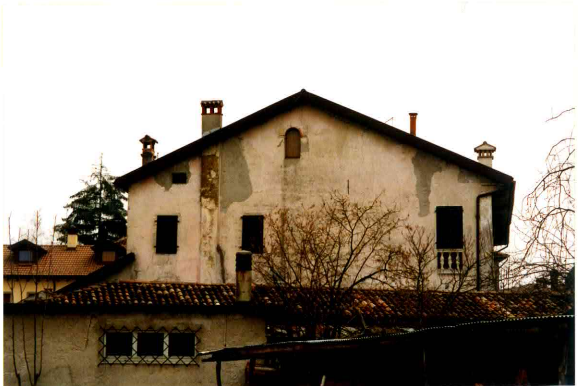
FACCIATA LATO OVEST
