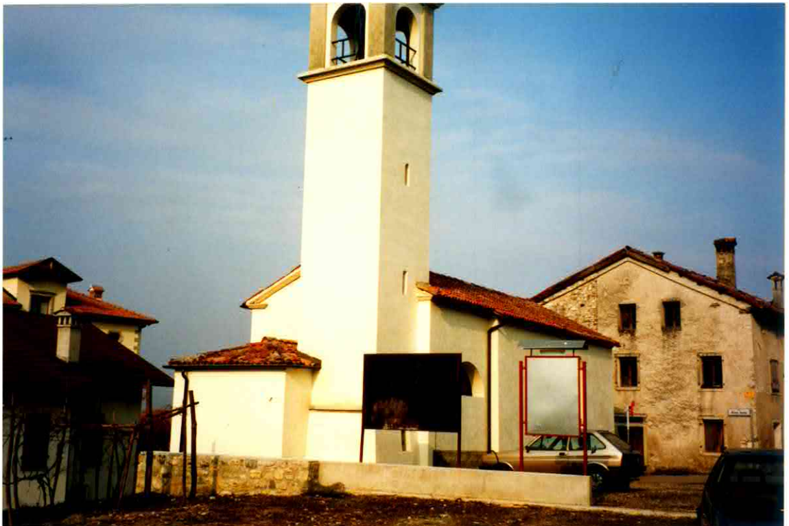
FACCIATA LATO SUD-OVEST
