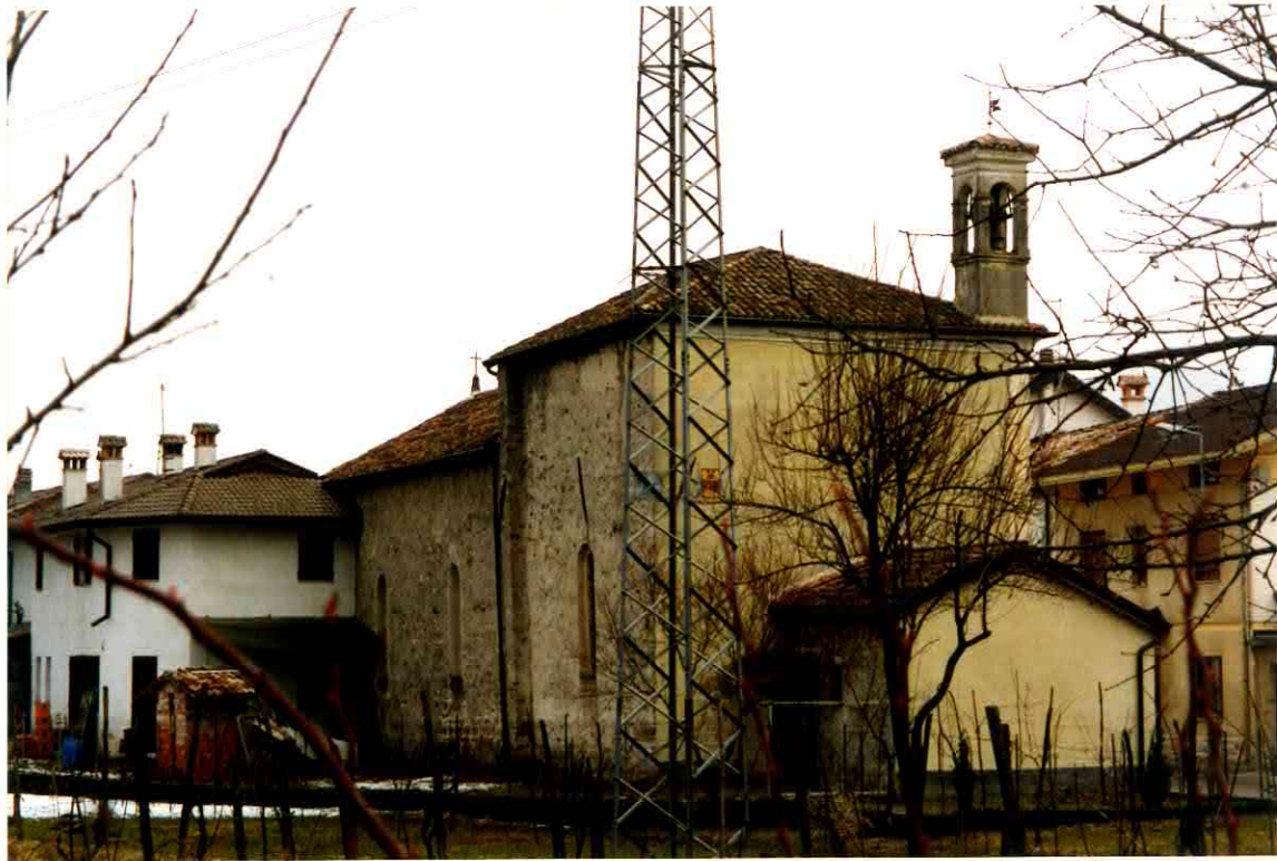
FACCIATA LATO NORD-OVEST
